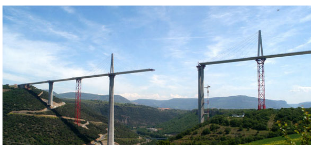
Le viaduc de Millau avant la jonction
